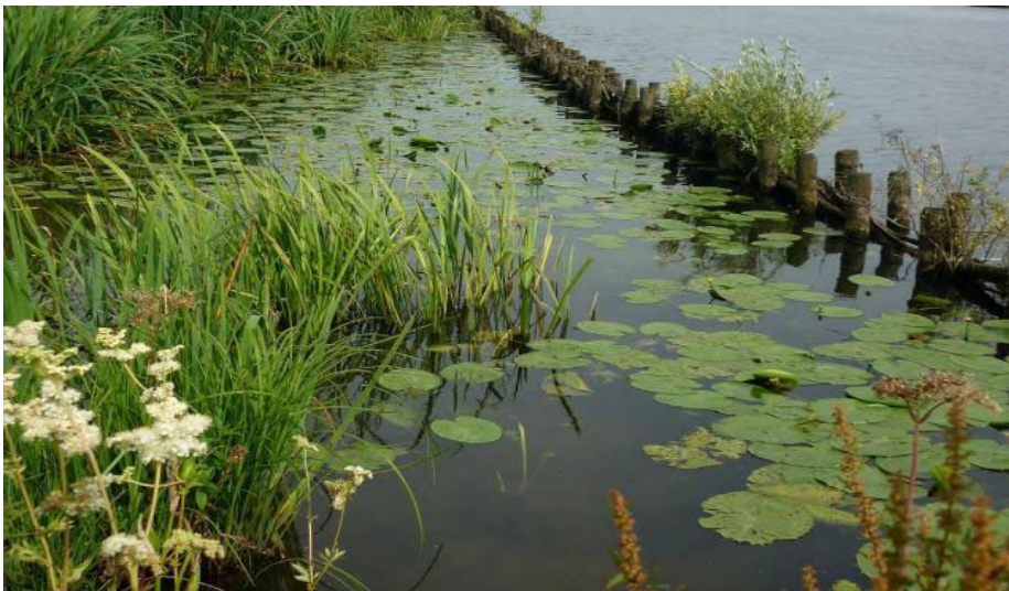
Figuur 3-25: Voorbeeld van een palenrij die bescherming biedt aan de achterliggende vegetatie
